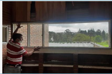
26) INSTALACIÓN DE RAJA METÁLICA PARA EVITAR PASO A CUBIERTA DEL ARCHIVO DOCUMENTAL.
