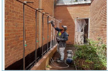
24) PINTURA CON ANTICORROSIVO DE ESTRUCTURA METÁLICA PARA SOPORTE DE LAS 19 DUCHAS PROVISIONALES.
