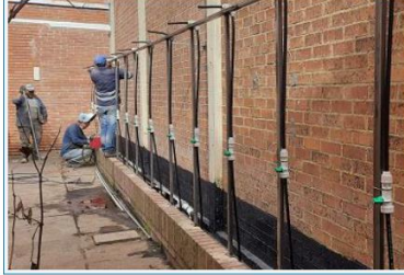
23) FABRICACIÓN E INSTALACIÓN DE ESTRUCTURA METÁLICA PARA SOPORTE DE LAS 19 DUCHAS PROVISIONALES.
