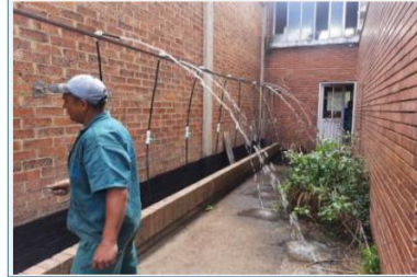
21) PRUEBA DE FUNCIONAMIENTO DE LAS 19 DUCHAS PROVISIONALES
