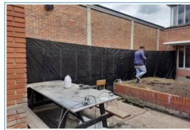
42) INSTALACIÓN DE POLI SOMBRA PARA DIVISIÓN DE 19 DUCHAS PROVISIONALES.
