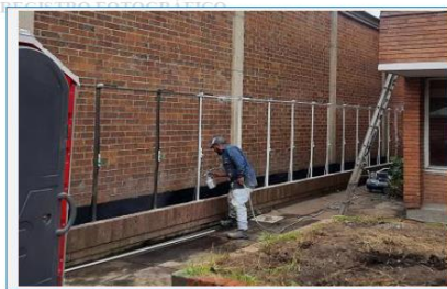
25) PINTURA CON ANTICORROSIVO DE ESTRUCTURA METÁLICA PARA SOPORTE DE LAS 19 DUCHAS PROVISIONALES.
