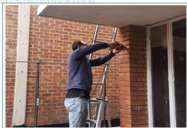
40) INSTALACIÓN DE GUAYA PARA INSTALACIÓN DE POLI SOMBRA PARA DIVISIÓN DE 19 DUCHAS PROVISIONALES.
