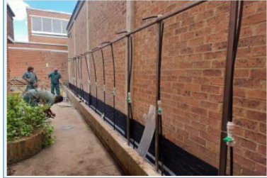
22) FABRICACIÓN E INSTALACIÓN DE ESTRUCTURA METÁLICA PARA SOPORTE DE LAS 19 DUCHAS PROVISIONALES.
